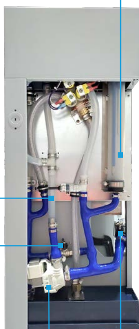
Pompe de drainage motorisée
