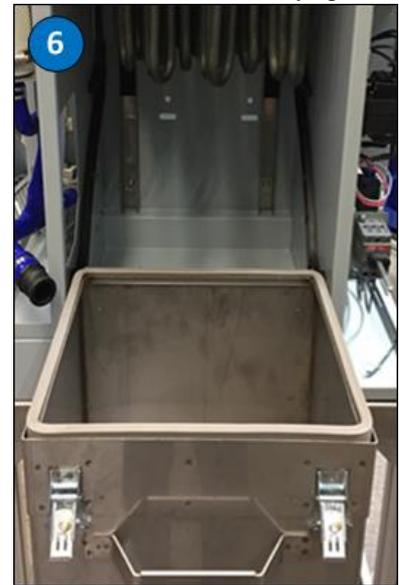
1. Avec la porte d'accès avant enlevée, débranchez l'entrée d'eau fixée à l'avant de la chambre d'évaporation, en retirant les goupilles de sécurité et en déconnectant manuellement le raccordement du tuyau d'entrée d'eau de la section de plomberie de l'humidificateur. Connectez et fixez le bouchon d'eau à l'entrée, afin d'empêcher l'eau de s'échapper de la chambre d'évaporation.
