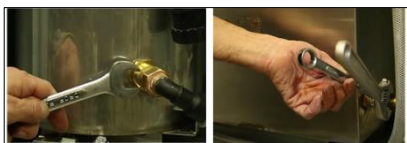
Serrer connecteurs en laiton
