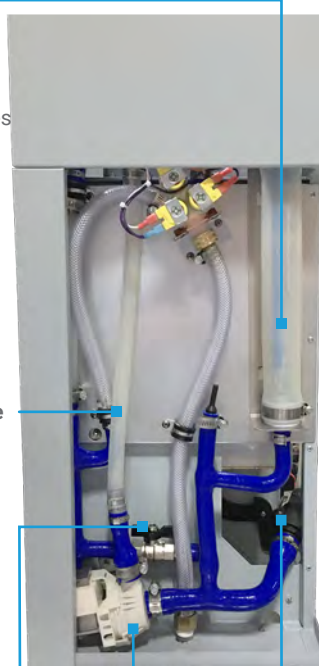
Pompe de drainage motorisée
